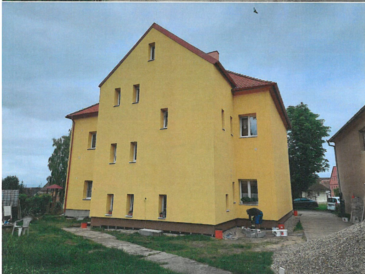
Zateplení fasády domu čp. 101 Malešov – náklady 1 424 tis. Kč
